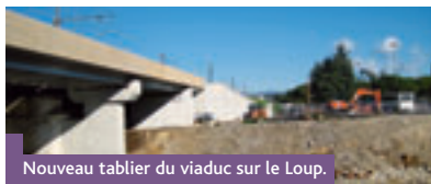
Nouveau tablier du viaduc sur le Loup.
