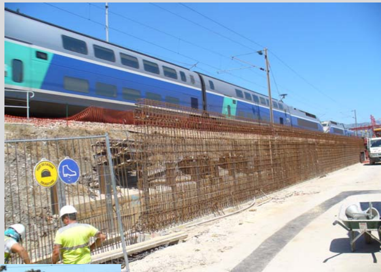
Réalisation de murs de soutènement
